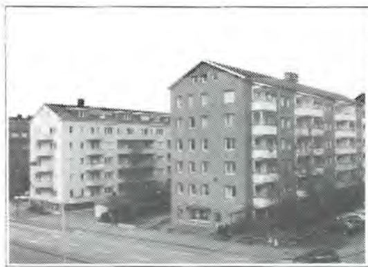
Hus i kvarteret Kapellet mot Kopparmöllegatan. Huset till vänster, Kapellet 13, är i stort sett oförändrat sedan det byggdes, medan Kapellet 19 till höger har fått ny fasad och nya balkonger.
