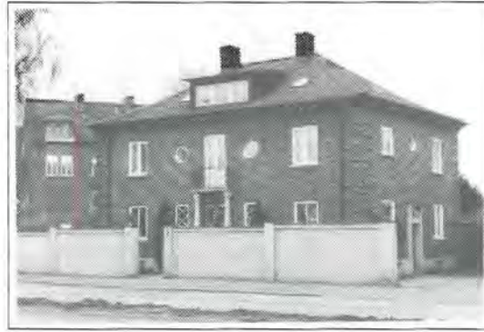
Södra Stenbocksgatan 8, kv Gladan 9. Byggnaden har många drag, typiska för 1920-talet, med symmetrisk fasaduppbyggnad och vita fönstersnickerier mot en mörk tegelfasad.
