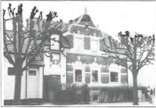
Olympiavägen 16, kv Gladan 6. Ursprunglig fasaddekor men sentida fönster.
