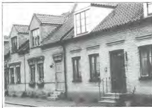
Fasader mot Bergströmsgatan av Pilen Norra 7, 8 och 9.
