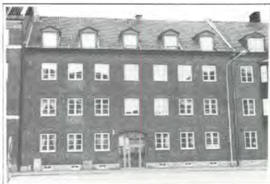
Ugglan 4, Mellersta Stenbocksgatan 41. Huset har försetts med en ny glasad port men är i övrigt välbevarat.
