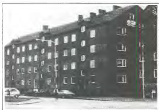
Bostadshuset vid Fredriksdalsplatsen från 1950-talet har många för tiden typiska detaljer, bl.a. de sexkantiga fönstren i trapphuset.
